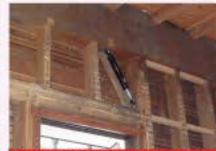
3年前に日光の木造3階建・ホテルの耐震改修で使用した制震ダンパーです。当時はメーカーに性能表示をお願いしました。
