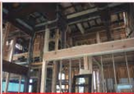
耐震補強工事では設計者と大工の技術力とコンビネーションが最重要です。力学的な知識と的確な判断力が求められます。
